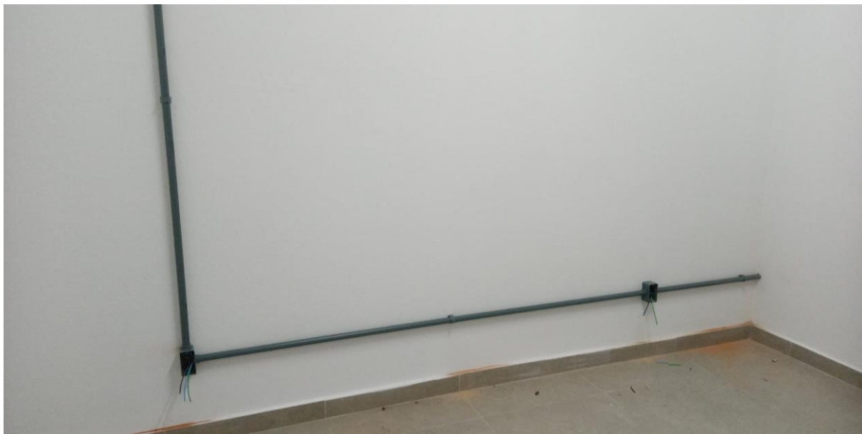
Novo projeto elétrico e execução
