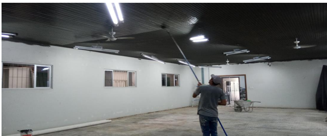
Pinturas das paredes e do teto
