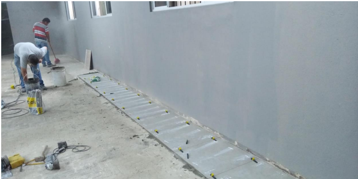
Colocação do piso cerâmico
