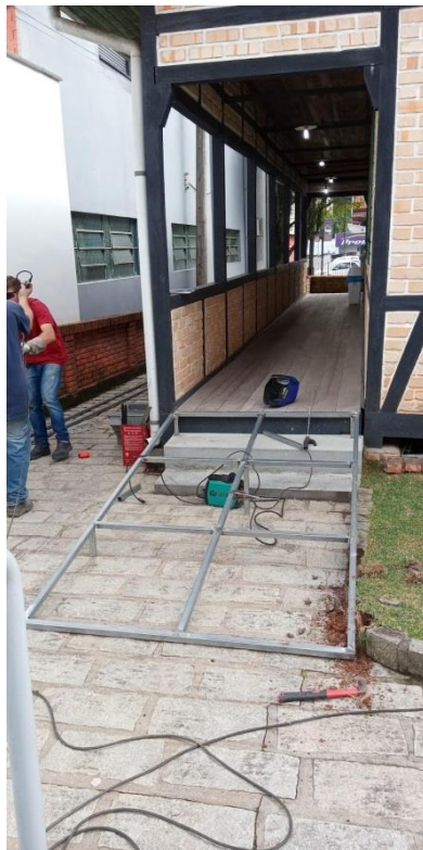
Instalação da rampa de acesso no espaço da Casa Enxaimel
