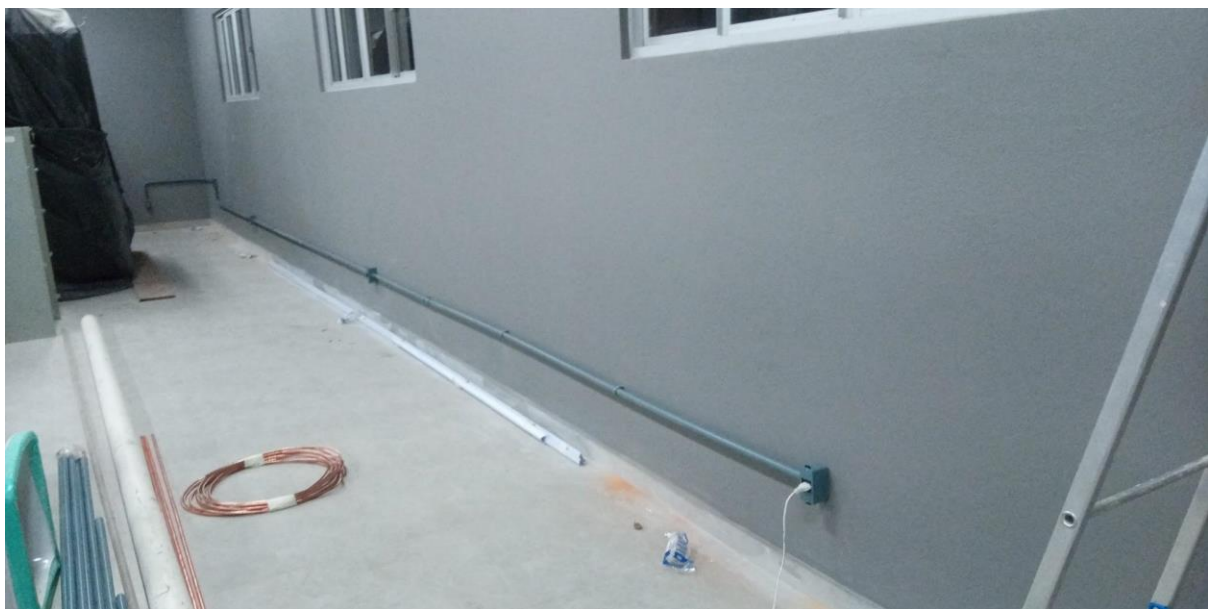
Novo projeto elétrico e execução
