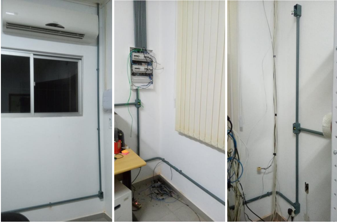
Novo projeto elétrico e execução
