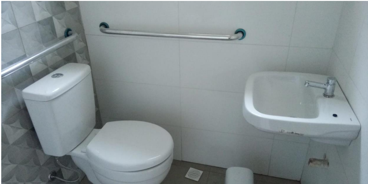
Colocação dos pisos de cerâmicos e novas louças nos banheiros
