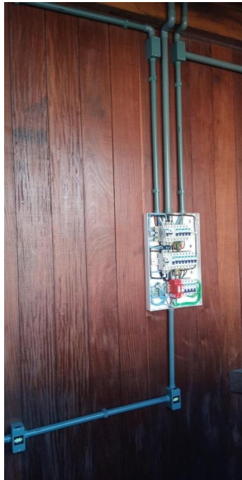
Novo painel elétrico
