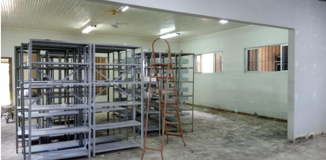
Piso com tacos de madeira sendo retirados
