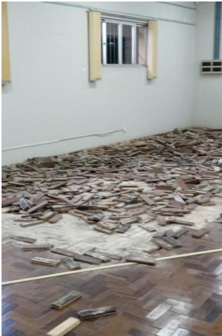
Piso com tacos de madeira sendo retirados
