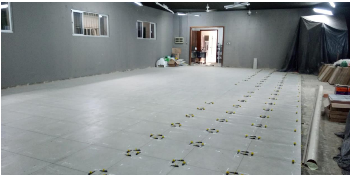
Colocação do piso cerâmico
