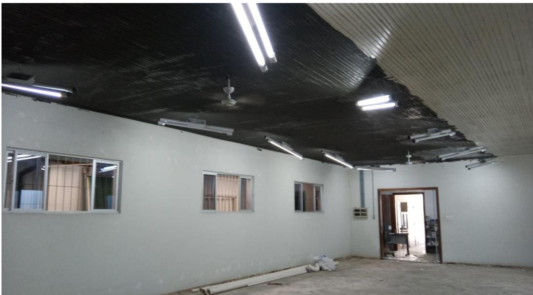
Pinturas das paredes e do teto
