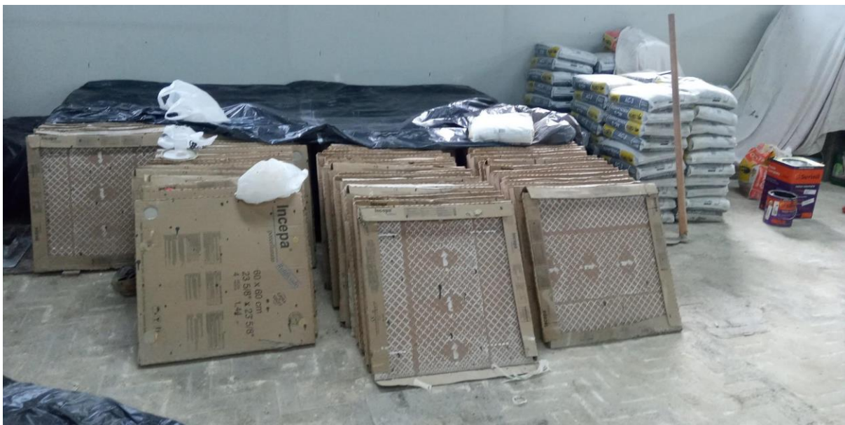
Colocação do piso cerâmico
