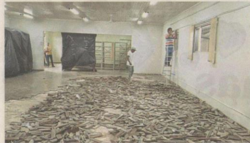
Trabalhos estão em andamento
