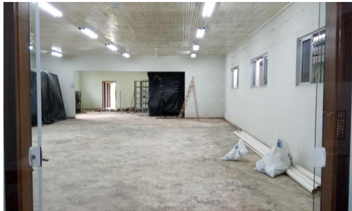
Piso com tacos de madeira sendo retirados
