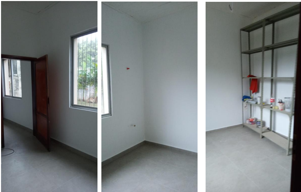
Piso colocado nos cômodos da área do fundo
