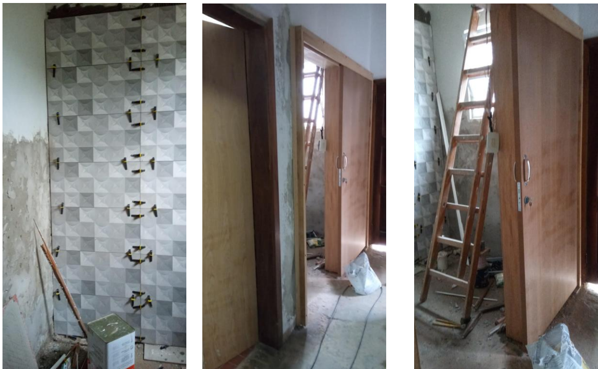
Colocação de pisos cerâmicos nos banheiros e portas de madeira nos banheiros para acessibilidade
