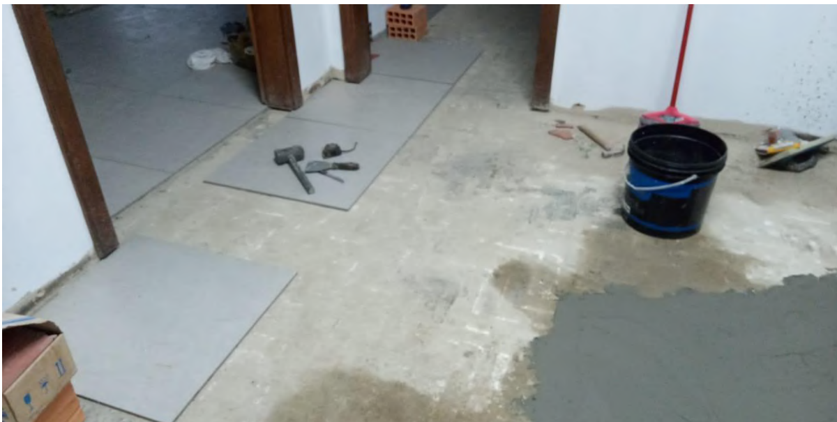
Piso cerâmico sendo colocado na nova área de secretaria
