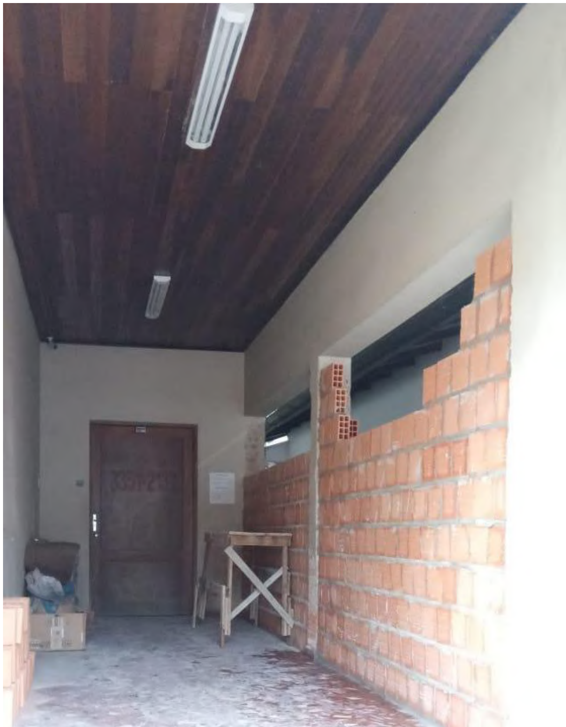
Construção de uma parede na entrada do museu
