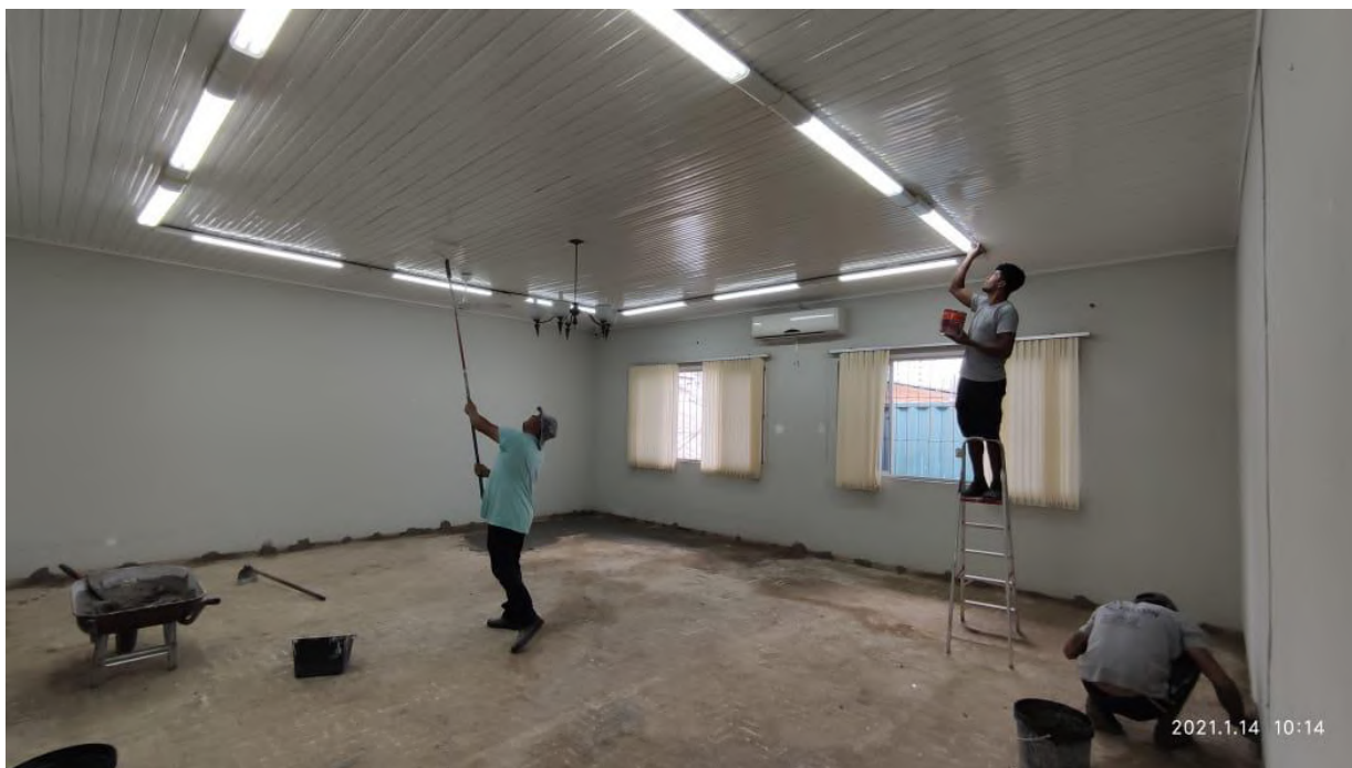
Pintura do forro e das paredes
