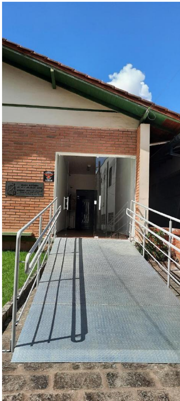
Novo acesso ao museu com a colocação da porta de vidro e da rampa para promover acessibilidade.
