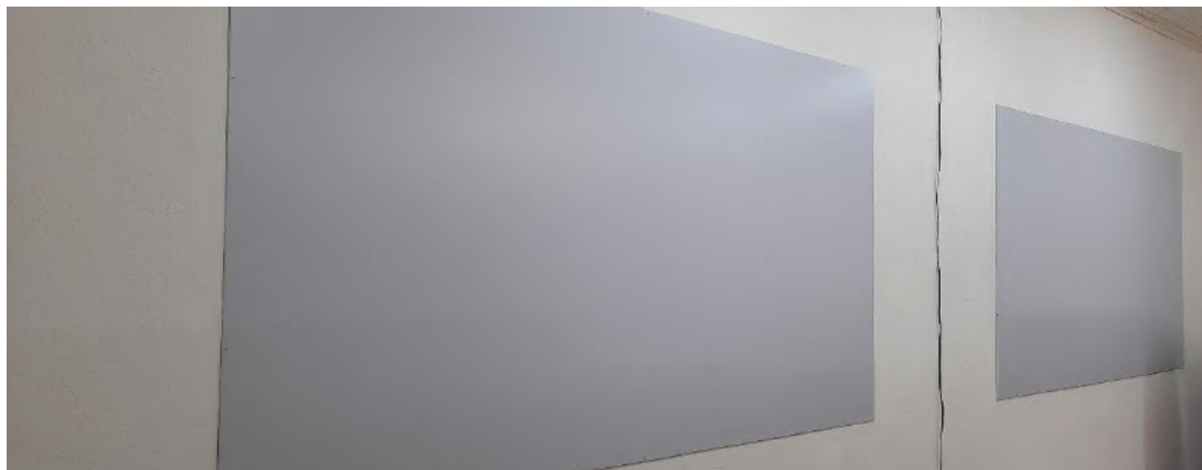
Placas ACM colocadas nas janelas
