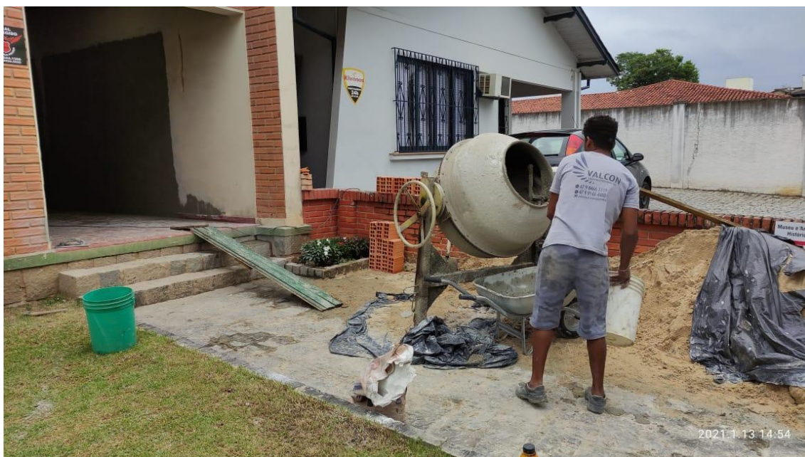
Serviço dos pedreiros contratados pelo projeto
