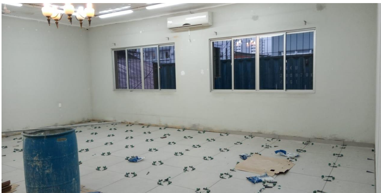
Colocação do piso cerâmico
