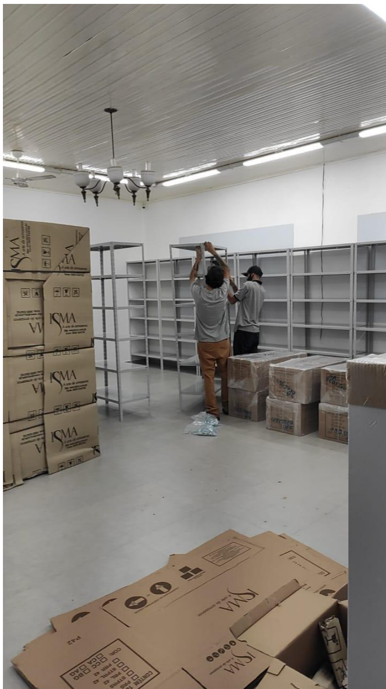
Montagem dos móveis de aço
