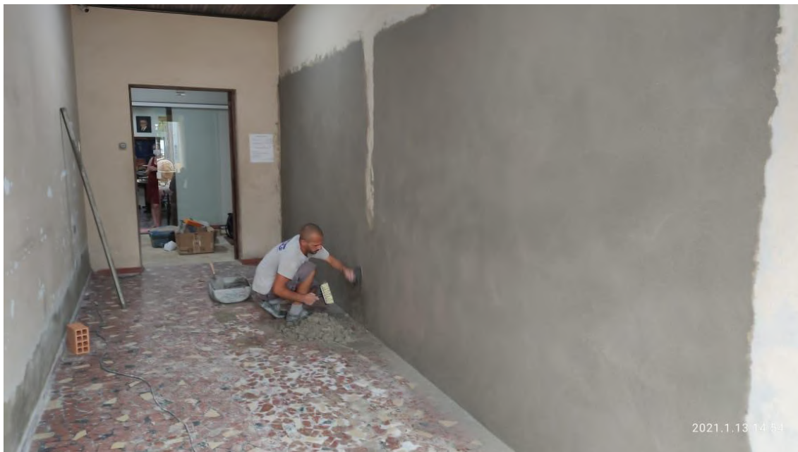
Pedreiro trabalhando na finalização da parede na entrada do museu
